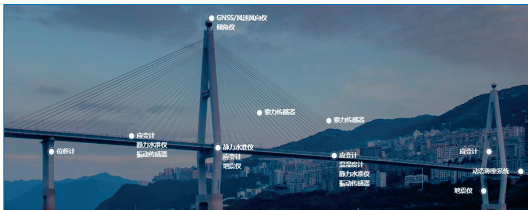
桥梁全量化安全监测
