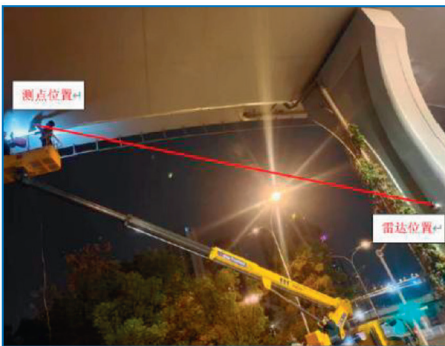
桥梁雷达挠度监测
