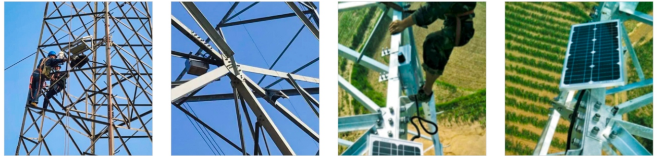
图为泰斗北斗高精度杆塔倾斜监测装置在河南、山东某地现场安装施工图
