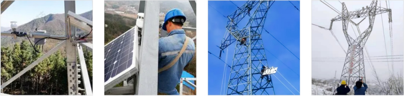
图为泰斗覆冰监测装置在青海某地现场安装施工图
