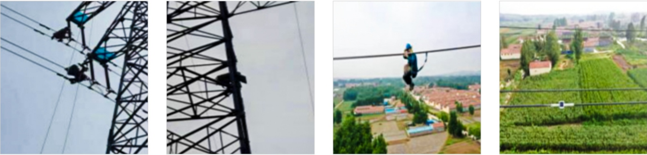
图为泰斗舞动监测装置在山东、山西某地现场安装施工图
