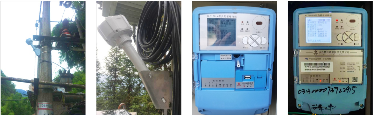
图为泰斗嵌入式北斗计量远程通信终端在贵州、广西、广东某地现场安装图
