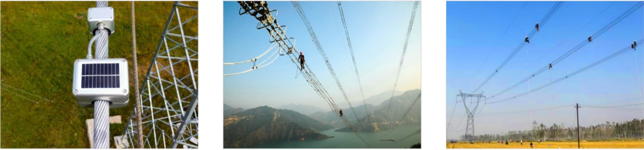
图为泰斗微风振动监测装置在湖北、甘肃某地现场安装施工图
