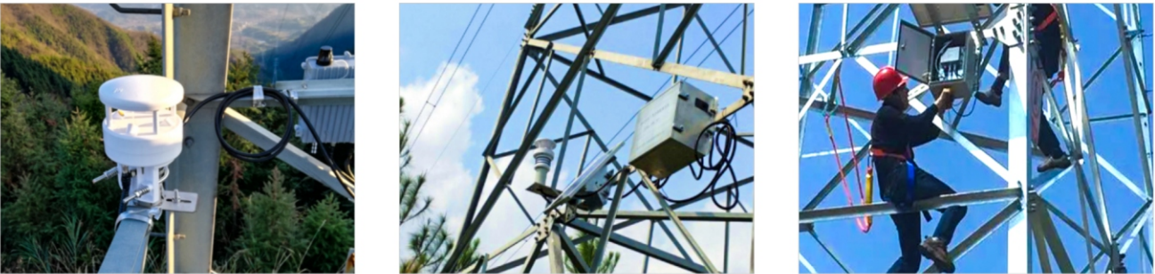
图为泰斗微气象监测装置在河北某地现场安装施工图
